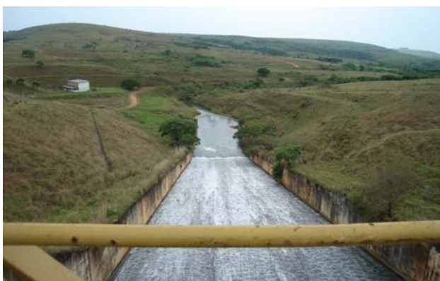
FIGURA 2 - Vertedouro do barramento no ribeirão do Inferno, Tapira/MG, montante do ponto amostrado, outubro/2008.
