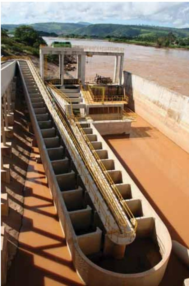
FIGURA 9 - Escada para transposição de peixes na Usina Hidrelétrica de Aimorés, MG.
