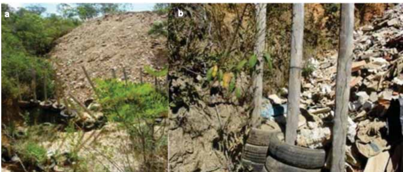
FIGURA 4 – A) montante de lixo depositada dentro do trecho 1 da voçoroca e B) paliçadas de pneu contendo o desmoronamento da montante de lixo.
