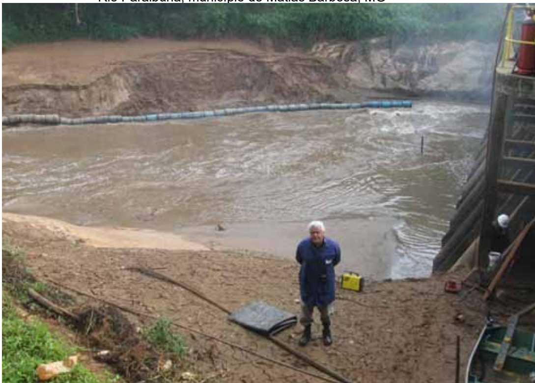
Fotografia 4 – Vista lateral, barragem da PCH Paciência, em descarga de fundo, Rio Paraibuna, município de Matias Barbosa, MG
