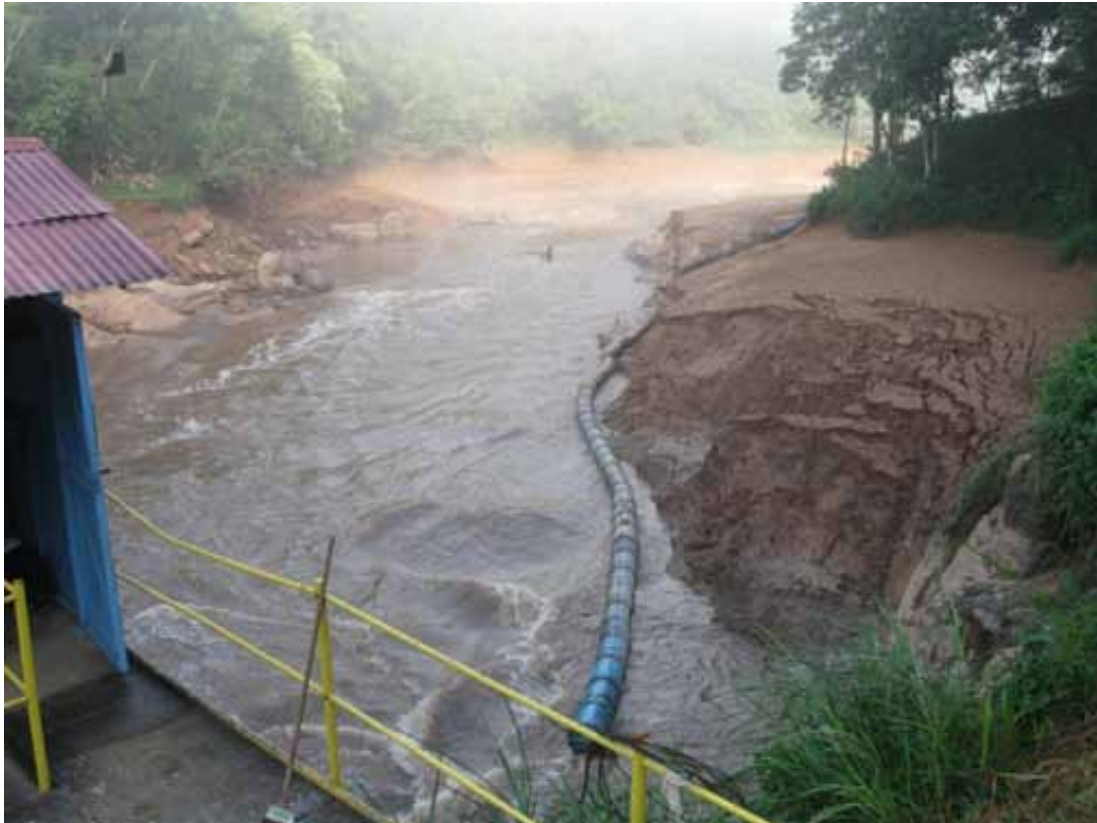
Fotografia 3—Vista para montante da barragem da PCH Paciência, em descarga de fundo. Rio Paraibuna, município de Matias Barbosa, MG
