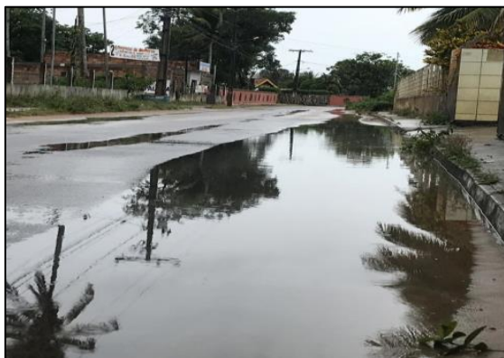
Fotografia 1 – Lâmina d'água próximo a bocas de lobo
